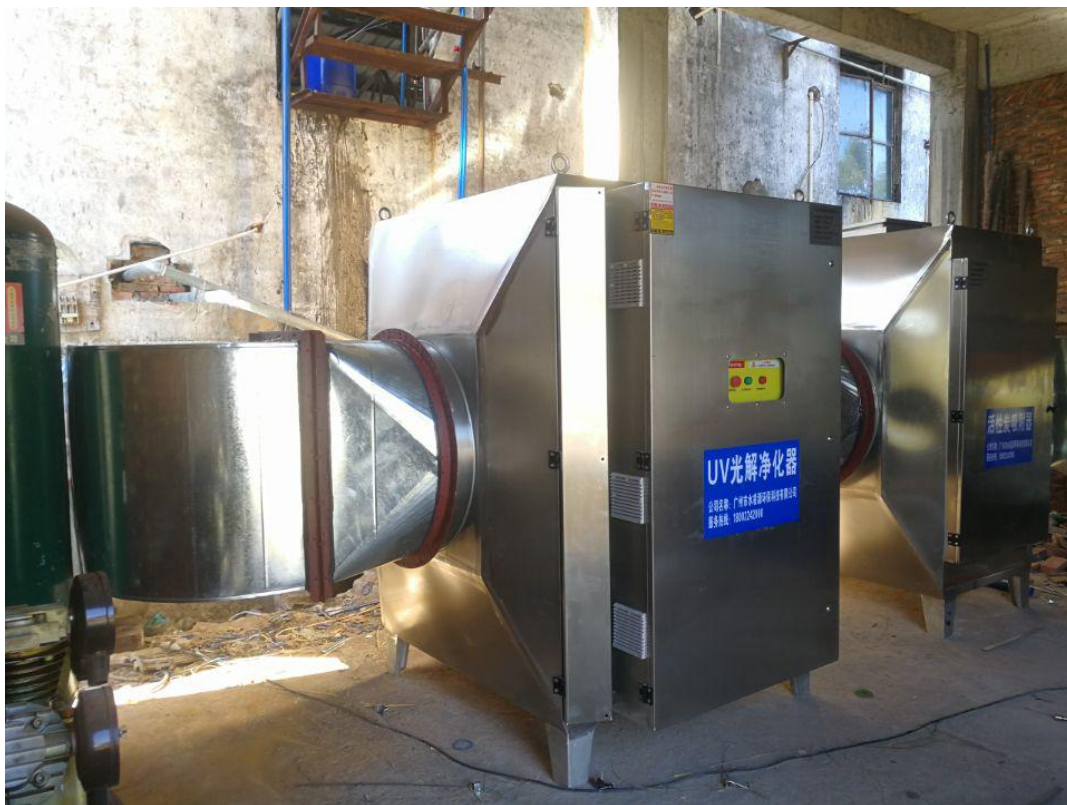
图 6.2-3 UV 光催化净化处理装置照片
