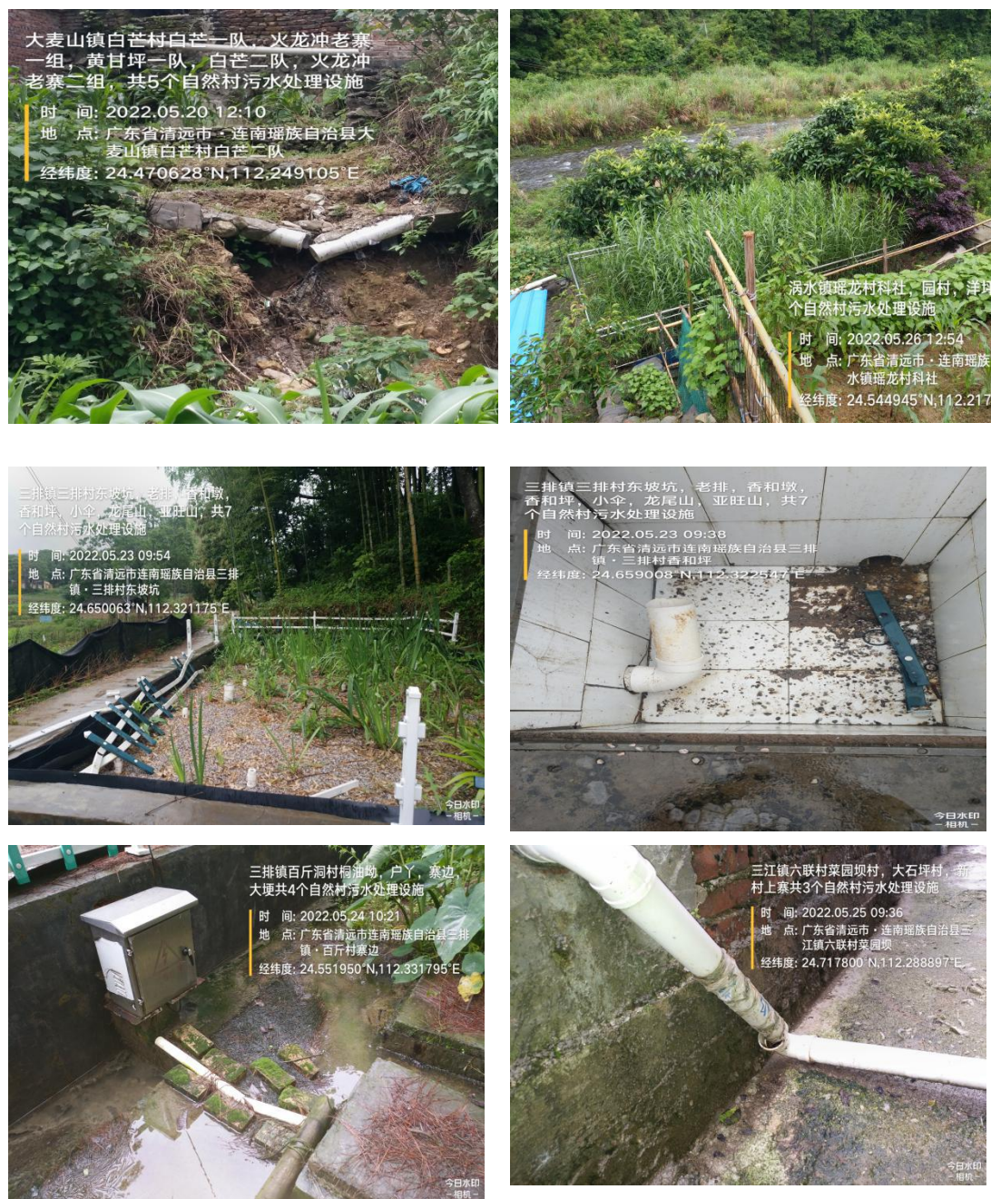
图 3-1 污水处理设施现场调研图片
