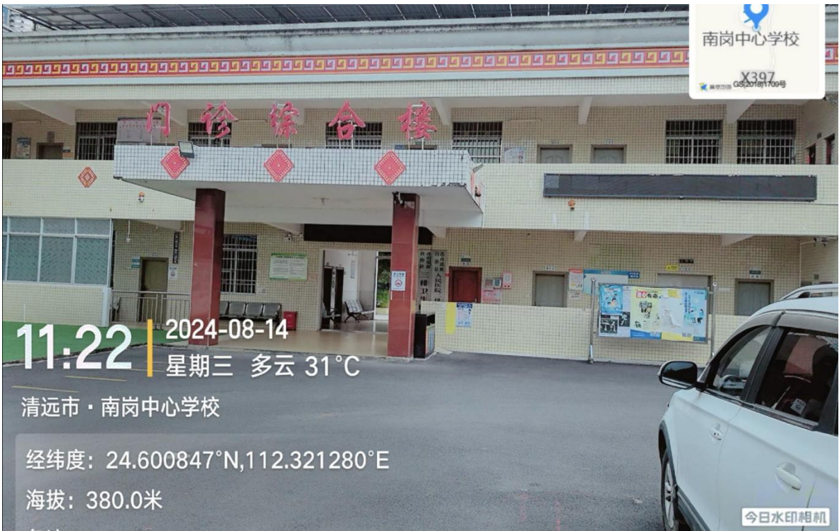
图一 三排镇卫生院原综合楼
