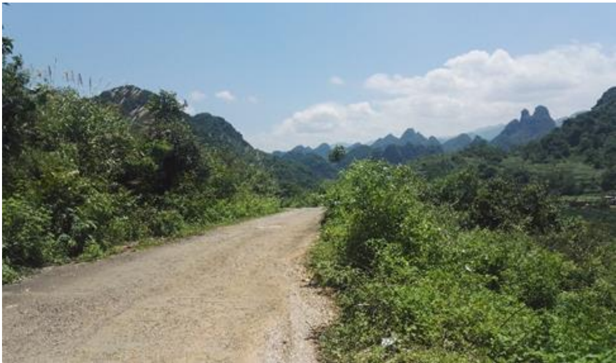
道路工程区现状（二）
