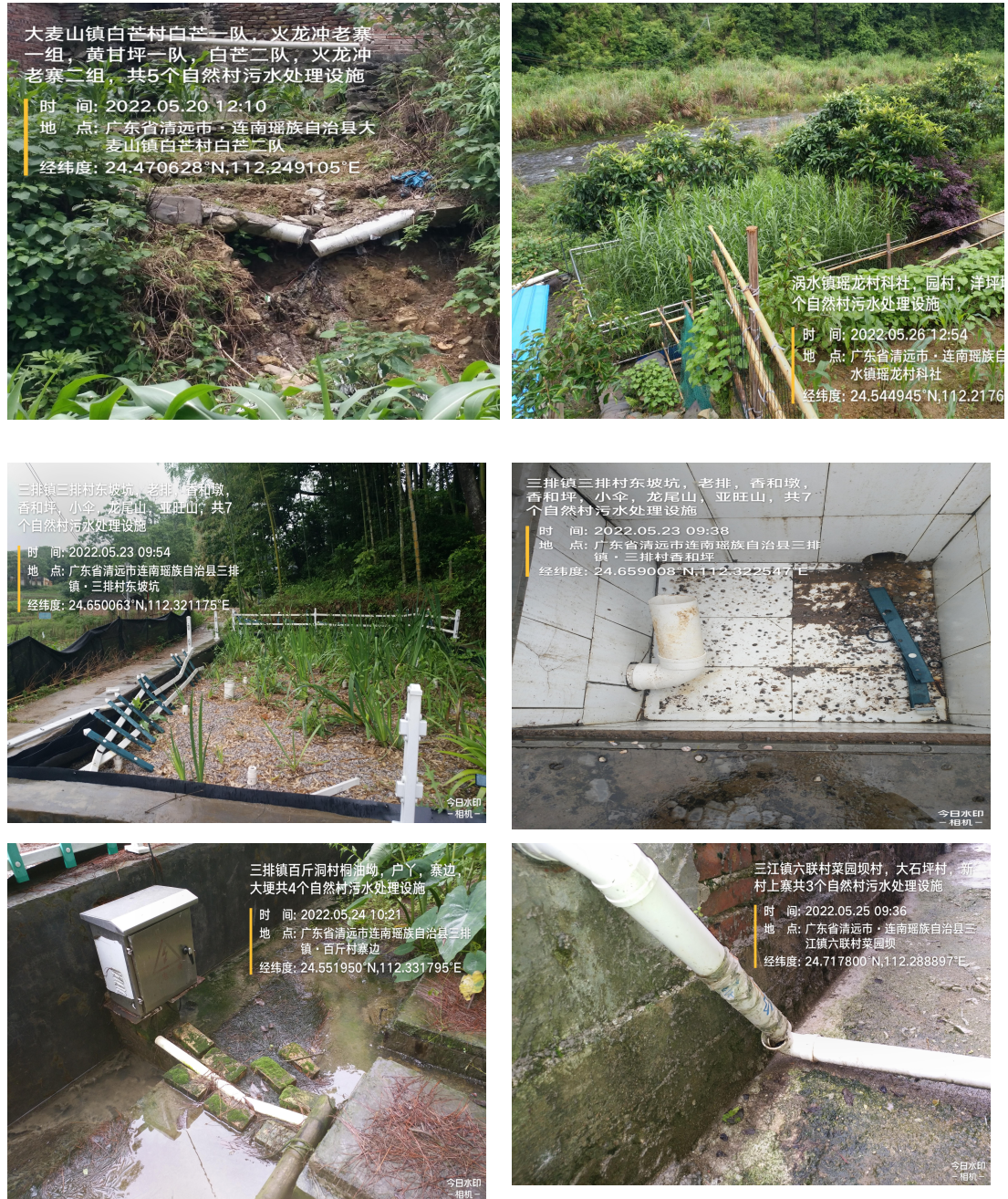
图 3-1 污水处理设施现场调研图片
