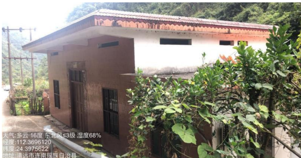
图 5-31 水园潭水电站现场照片
