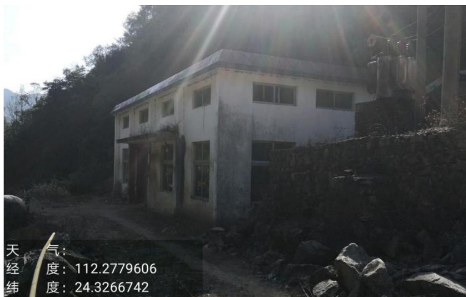
图 5-39 桥头坑水电站现场照片
