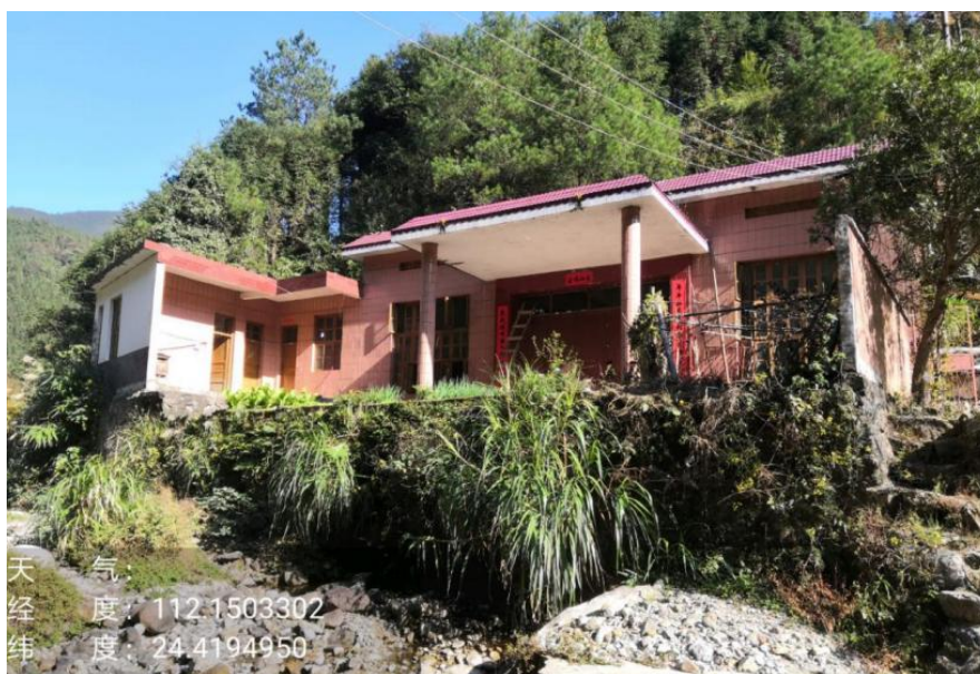
图 5-49 万坑一级水电站现场照片
