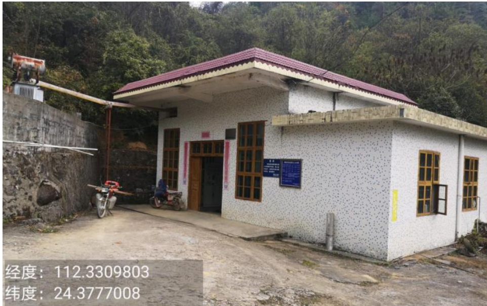
图 5-32 源塘水电站现场照片
