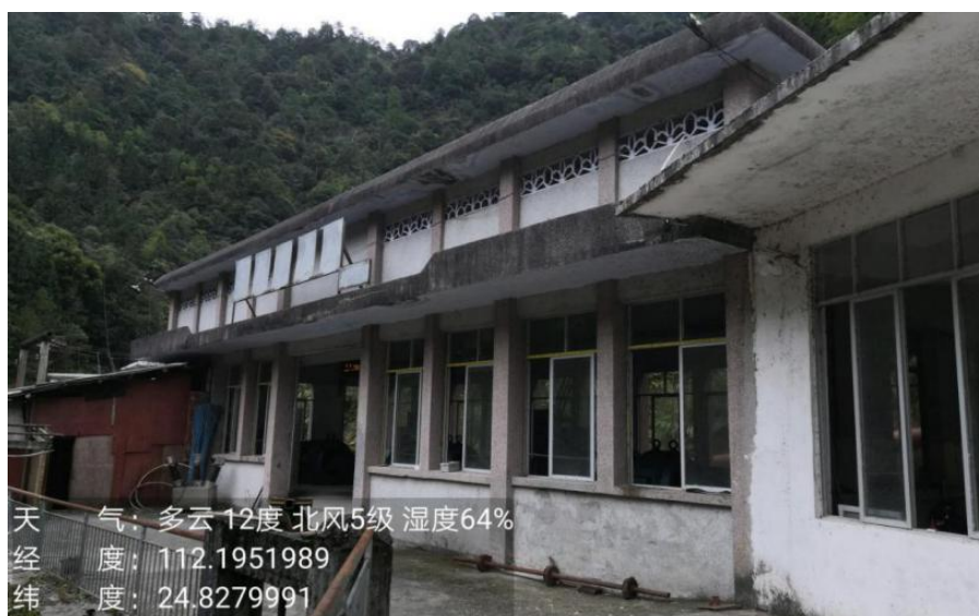
图 5-62 大龙山水电站现场照片
