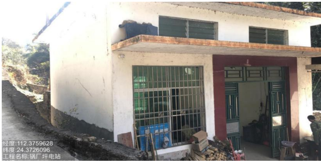
图 5-40 锅厂坪水电站现场照片
