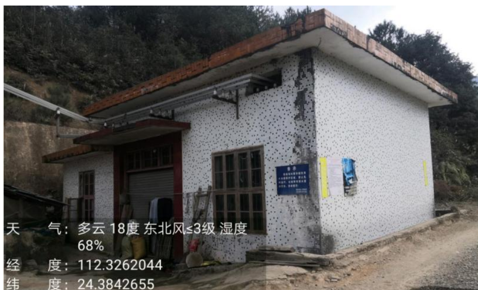
图 5-36 青塘水电站现场照片
