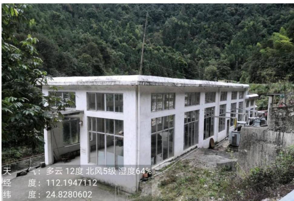
图 5-64 正龙水电站现场照片
