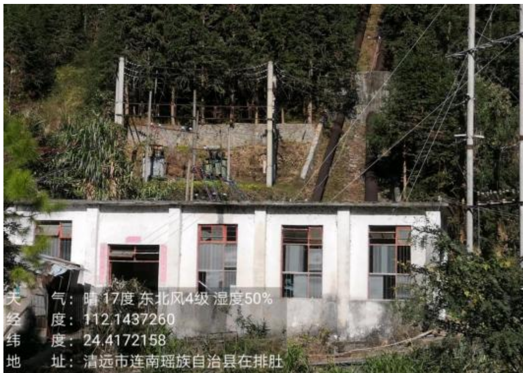
图 5-48 排肚万坑水电站水电站现场照片
