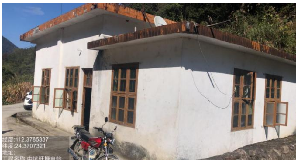
图 5-34 中坑旺塘水电站现场照片
