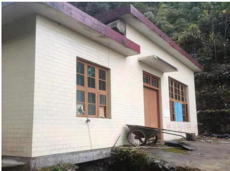
图 5-37 高丰河水电站现场照片
