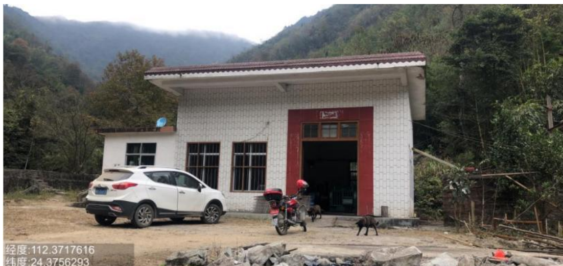
图 5-35 黑泗水电站现场照片
