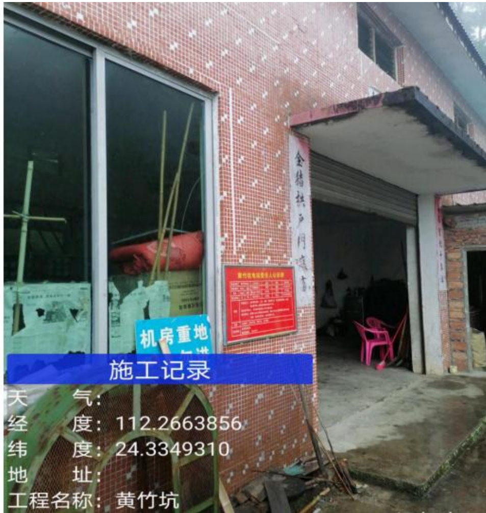
图 5-33 黄竹坑水电站现场照片
