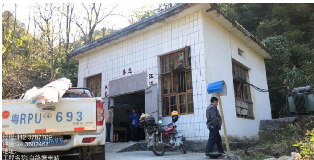
图 5-38 白鸽塘水电站现场照片
