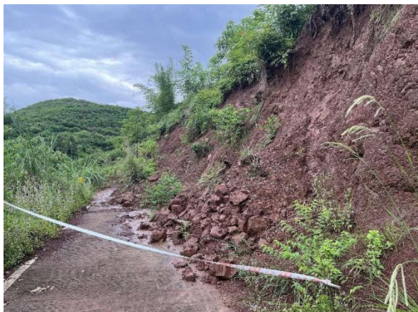
照片 7：金光片区现状路堑边坡崩塌 BT2（镜向 N） 照片 8：北侧寨岗河现状（镜向 E）
