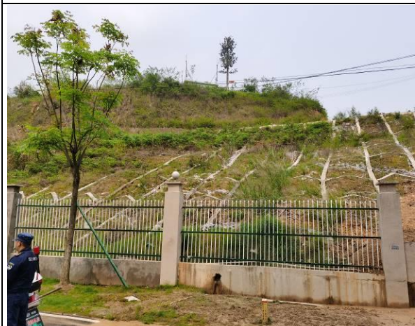
临时开挖边坡现状 (2020. 4. 10)
