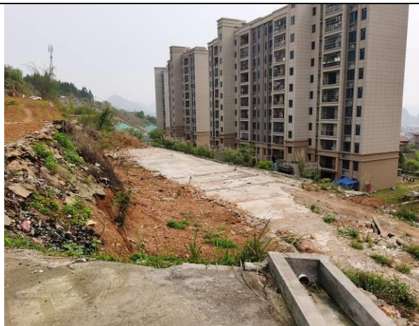
施工营造区现状 (2020. 4. 10)
